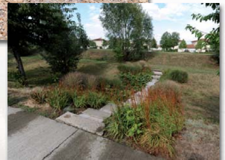
Corbas - Zac Bourlione Traversée piétonne dans noue
