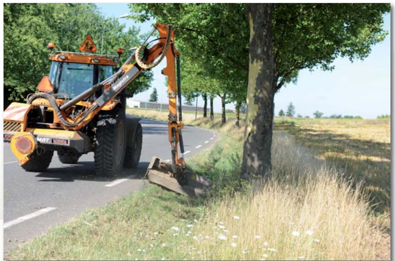
Fauchage d'un fossé
