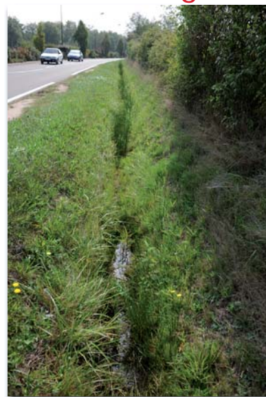
La Tour de Salvagny Av. du Casino Vue d'ensemble
