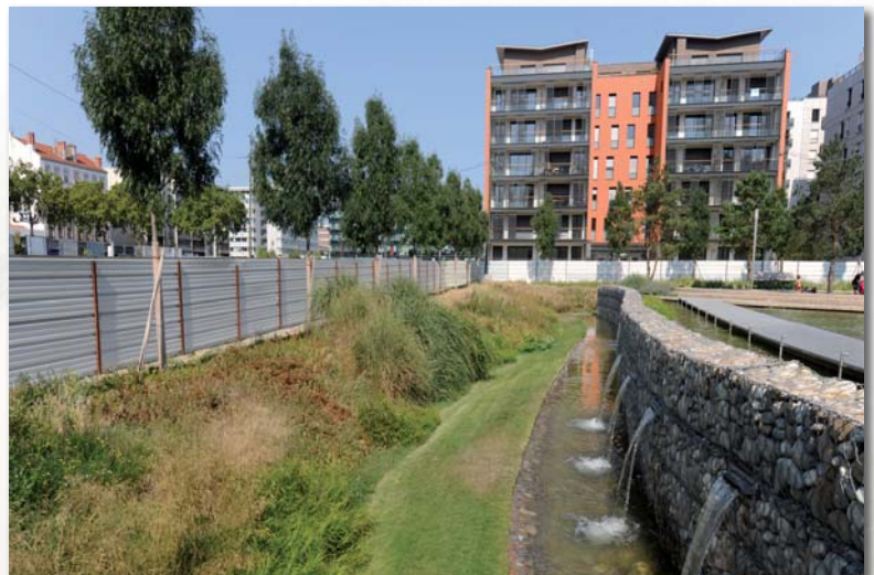
Lyon 3ème - Parc Jacob Kaplan Bassin d'infiltration
